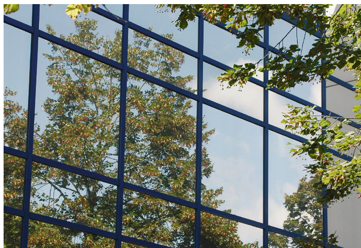
Facciate riflettenti © Stazione ornitologica svizzera
