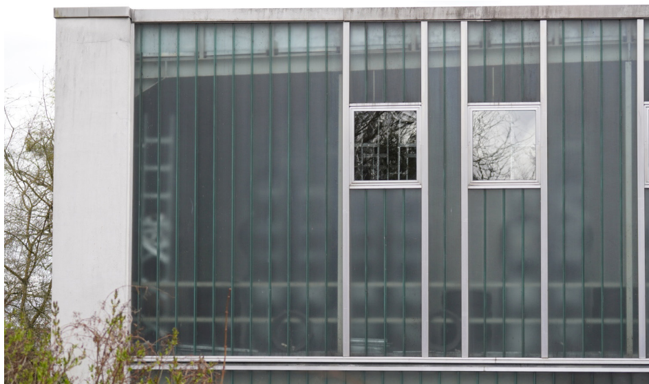
Il cosiddetto vetro da costruzione profilato consente alla luce di penetrare e allo stesso tempo fornisce privacy alle persone che si trovano nell'edificio. © Klemens Steiof
